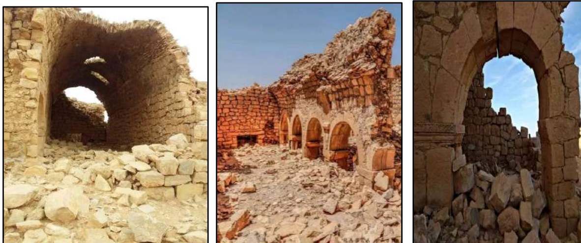
(صورة: 21) تأثير العوامل الطبيعية على مبني الكنيسة مما تسبب في تصدعات المبنى وانهيار الجدران والأقواس والسقف. تصوير الباحث.
